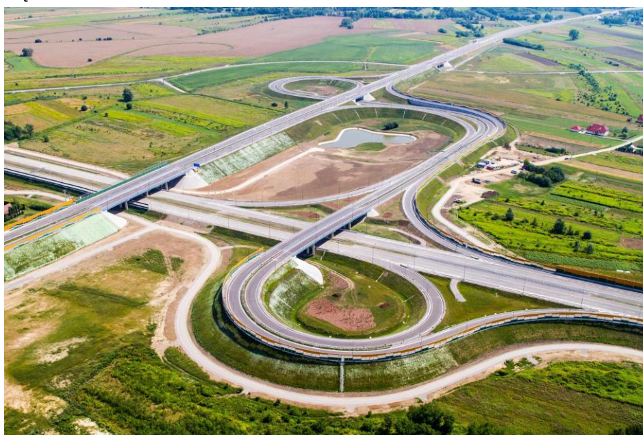
Węzeł Rzeszów Wschód
